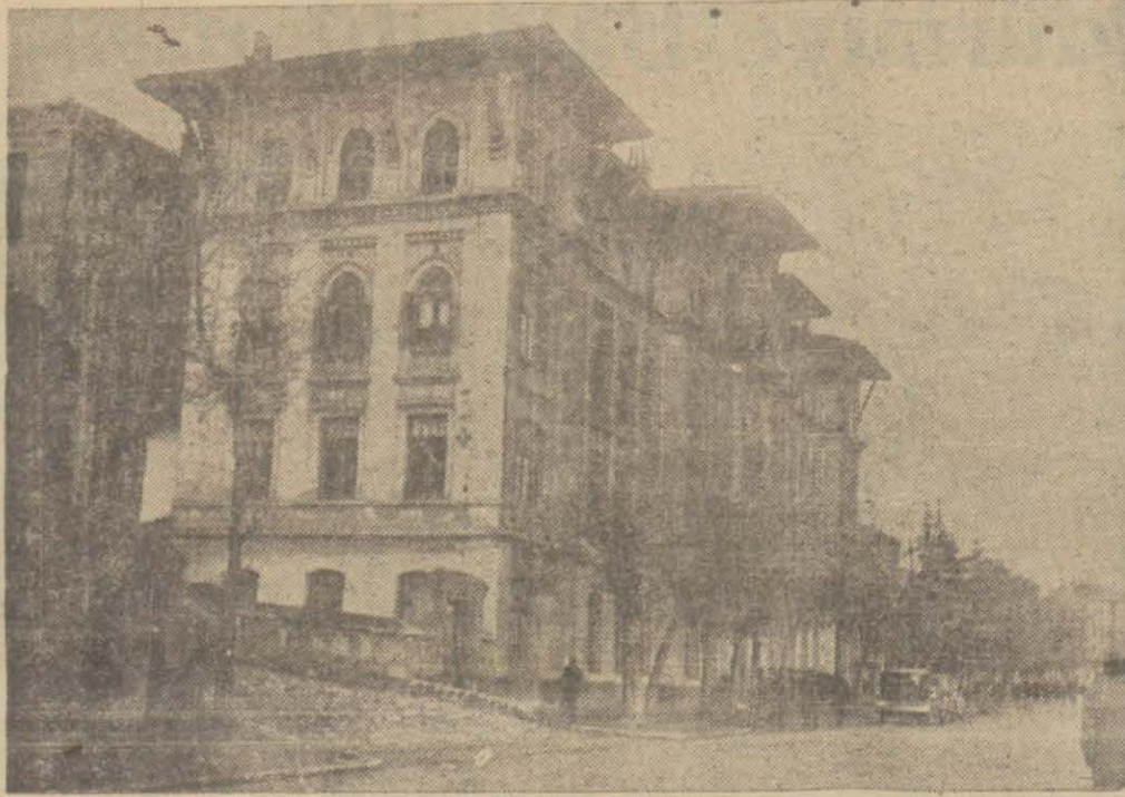
İstanbul Tapu Dairesinin binası
